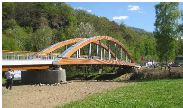
Schwerlastbrücke über die Agger Foto: Stadt Lohmar
