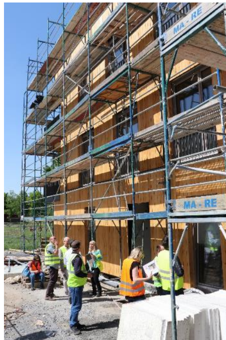
Bild 10: Sowohl die tragenden Wände als auch sämtliche Decken des Objektes in Potsdam werden in massiver Holzbauweise errichtet. Foto: Kollaxo
