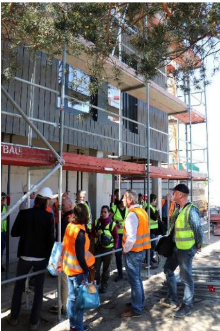
Bild 9: Vorgefertigte Holzfassaden-Elemente tragen zum schnellen Baufortschritt des Hybridbaus in Berlin-Adlershof bei. Foto: Kollaxo
